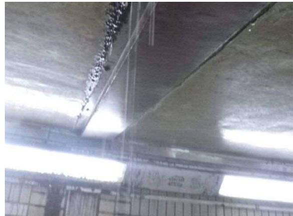
写真-2 天井面の継ぎ目より漏水している
